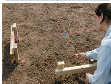
enplanta muntaĵo por teni liniajn fadenojn
