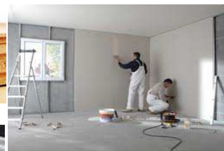
muntado da gips-paneloj sur rajloj
