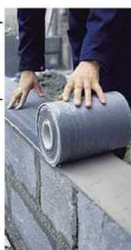
armita bitumo en muro
