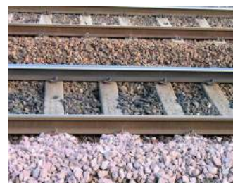
balasto sub trako (gruzo por bloki ŝpalojn)
