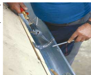
lutado sur pluvkanaletoj
