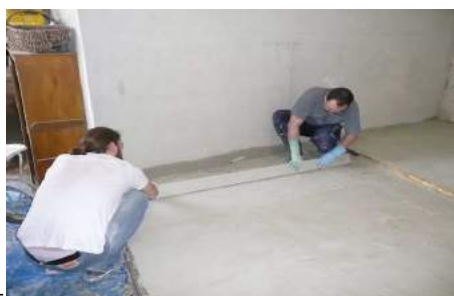
slabo el mortero kun akvokalko en la kastelo Greziljono
