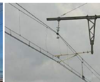
fervoja supertraka kontakta lineo
