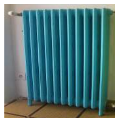
varmakva hejtilo por centra hejtado (radiatoro)
