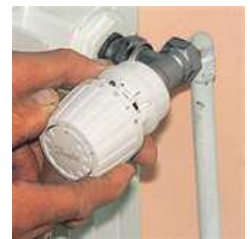
varmoregula kranok por radiatori
