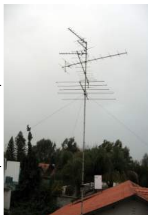
surtegmenta anteno per ultra alta frekvenco
