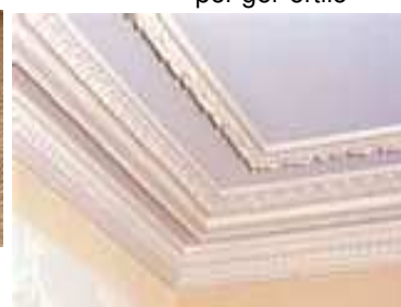
mulda gipsaĵo sur plafono
