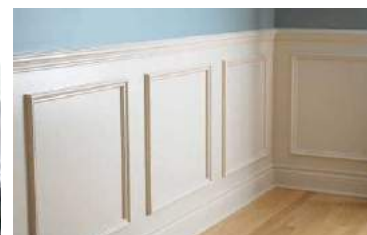
ligna tegotabulo sur baso de muro
