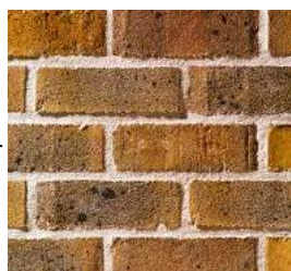
muro da plenbrikoj
